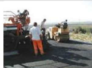
fig. 01 – Operazioni di finitura manto stradale
