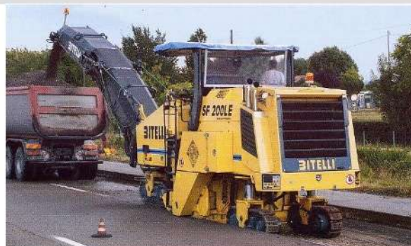
fig. 01 – Operazioni di scarifica in sede stradale
